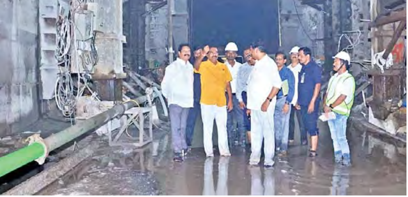
వెలిగొండ ప్రాజెక్టు టన్నెల్ లోపల పనులను పరిశీలిస్తున్న మంత్రి నిమ్మల రామానాయుడు
